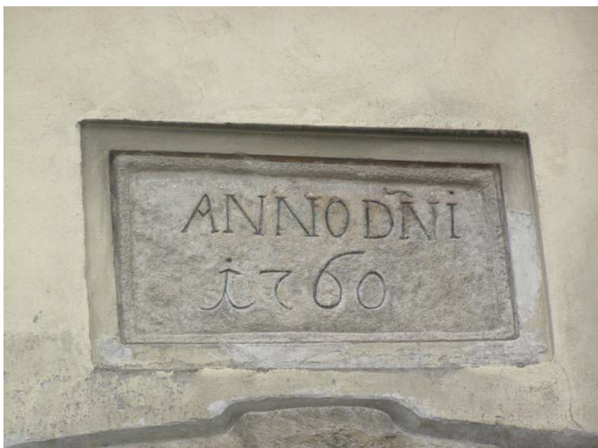
Slika 8. Ploča iznad sjevernog ulaza Kamenitih vrata
