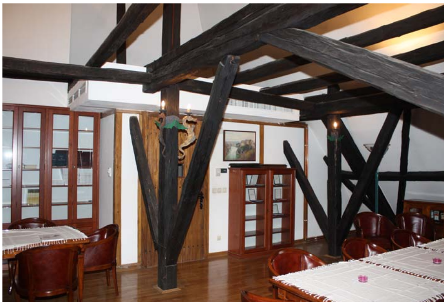
Slika 27. Novouređeno potkrovlje Kule nad Kamenitim vratima
